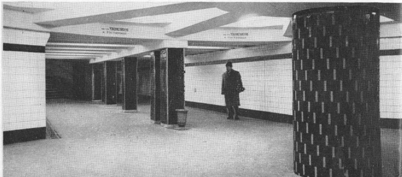
Подземный переход на Узбекистанской улице. Проект разработан институтом «Таш-гипрогор». Авторы проекта: архитектор Г. Александрович и инженер Р. Муфтахов. Осуществлен «Ленметростроем».
